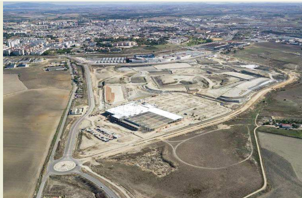
GESTOPO, S.C. colabora en la ejecución de IKEA-JEREZ.
